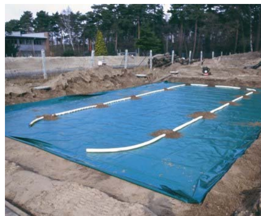
Abbildung 4: Verlegung Drainagerohr
