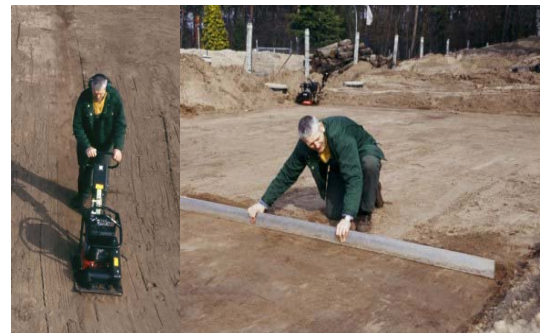
Abbildung 2: Verdichten und Feinplanum
