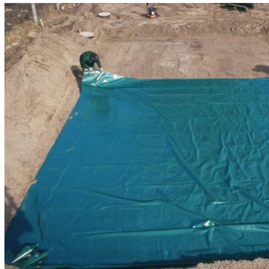
Abbildung 3: Auslegung der Folienwanne
