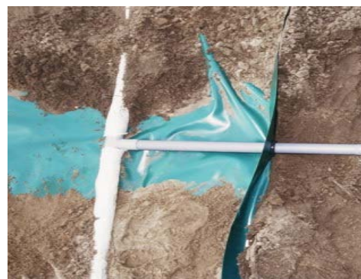
Abbildung 5: Rohranschluss Drainage
