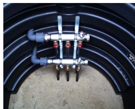
Abbildung 15: Verteilerschacht Garten mit montiertem Sole-Verteiler (nicht enthalten)
