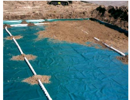
Abbildung 8: Anfüllung Drainage mit Sand
