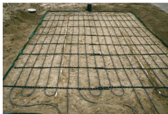
Abbildung 11: Fertig gestelltes Kollektorfeld
