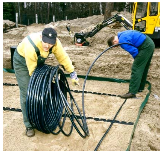
Abbildung 9+10: Verlegung Kollektorrohre
